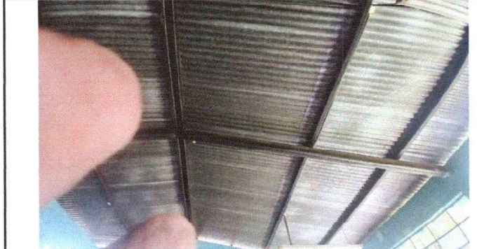
Foto 2: SUSTITUCIÓN DE COSTANERAS DE LA EORM COMUNIDAD MARICHAJ.
