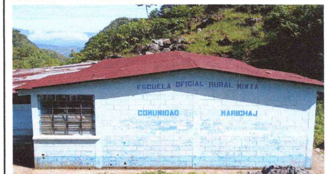
Foto 4: APLICACIÓN Y CAMBIO DE PINTURA EN PARED EXTERIOR
