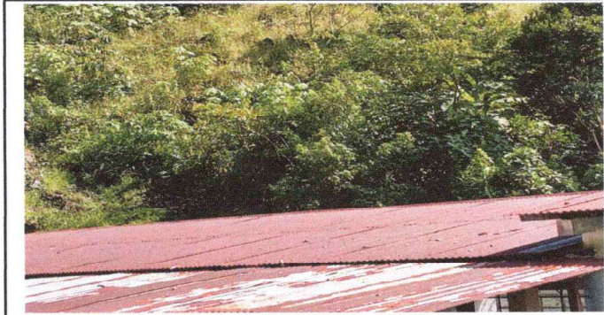
Foto1: SUSTITUCIÓN DE LÁMINAS, POR LÁMINAS TROQUELADAS, BAJADA DE AGUA PLUVIAL Y SU ESTRUCTURA DE TECHO.
