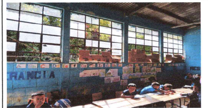
Foto 3: SUSTITUCIÓN DE VENTANAS DE LA EORM COMUNIDAD MARICHAJ
