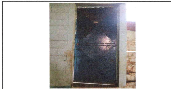
Foto 6: SUSTITUCION DE PUERTAS DE METAL DE LA EORM COMUNIDAD MARICHAJ.
